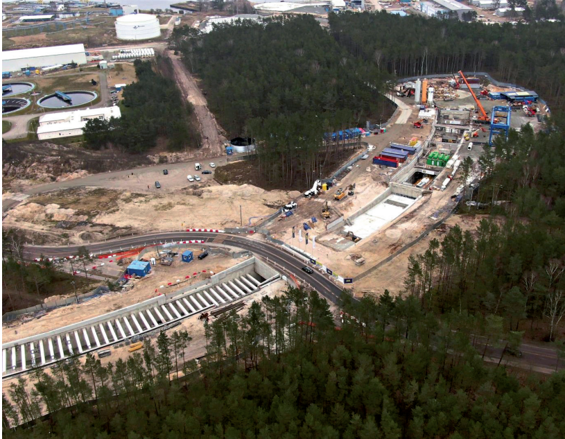
Budowa tunelu po stronie wyspy Uznam. Przez środek zdjęcia biegnie ulica Karsiborska. Po lewej wjazd do przyszłego tunelu.
