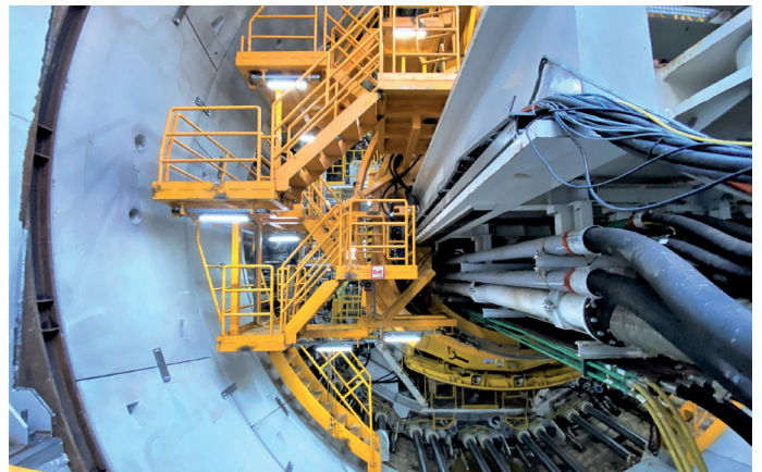
Na zdjęciu (po lewej stronie) widać pierwsze pierścienie obudowy ułożone przez maszynę TBM. A w prawym dolnym rogu siłowniki „Wyspiarzki”.
