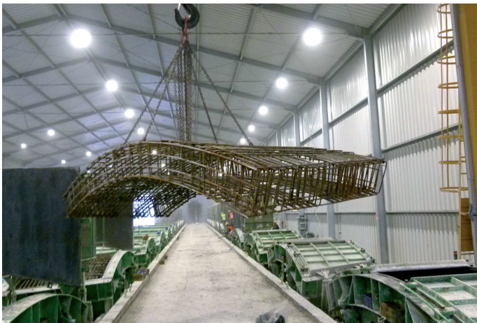
Zakład prefabrykatów na budowie tunelu po stronie wyspy Uznam. To tu powstają pierścienie obudowy tunelu.
