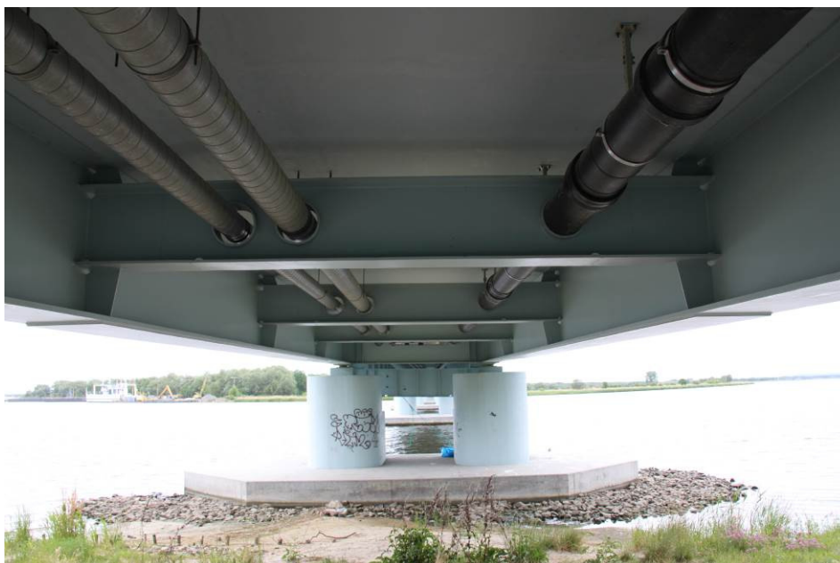
Rys. 2.7. Poprzecznice pełnościenne w skrajnych sekcjach obiektu
