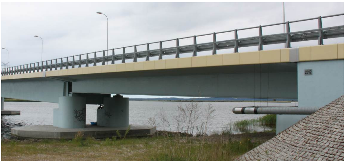
Rys. 2.5. Widok ogólny sekcji jednoprzęsłowej mostu – między podporami nr 9 oraz nr 10 (widok od strony dolnej wody)
