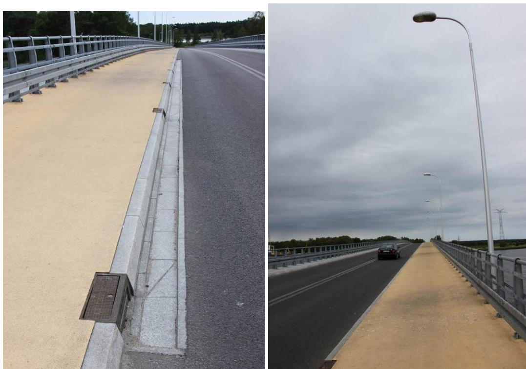
Rys. 3.28. Nawierzchnia jezdni oraz chodników – widok ogólny
