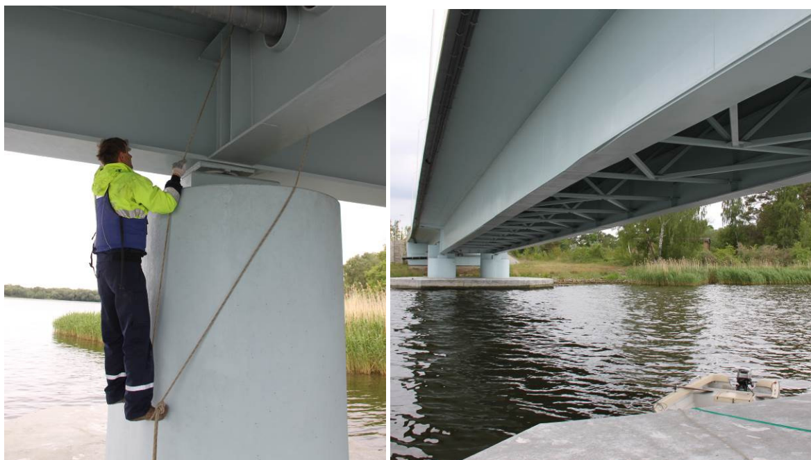
Rys. 3.1. Przegląd konstrukcji przęseł – wizualna ocena stanu elementów
