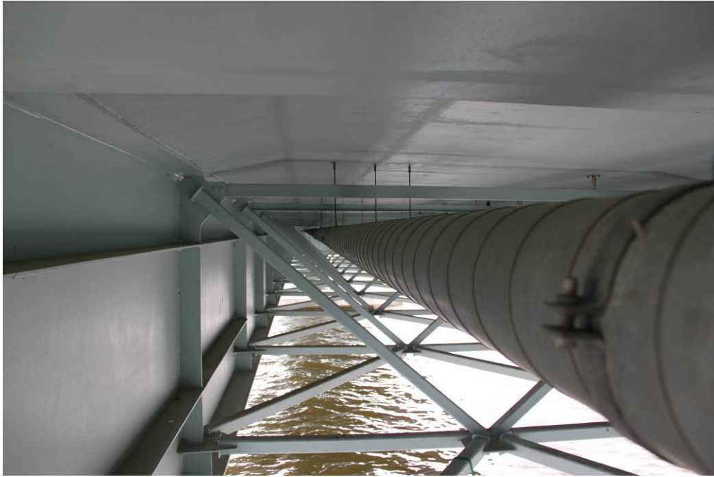
Rys. 3.19. Konstrukcja pomostu sekcji pięcioprzęsłowej między podporami nr 4 i nr 9
