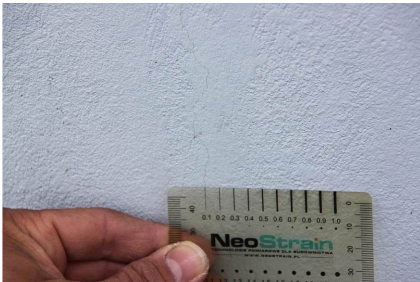
Rys. 4.5. Pomiar rozwartości rys z użyciem wzornika
