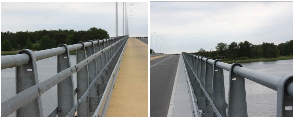
Rys. 3.42. Ogólny widok barieroporęczy na obiekcie: od strony górnej wody (po lewej) oraz dolnej wody (po prawej)
