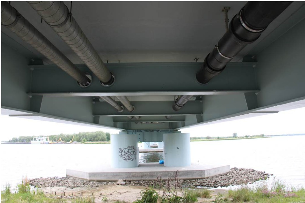
Rys. 3.20. Konstrukcja pomostu w prześle skrajnym 9-10
