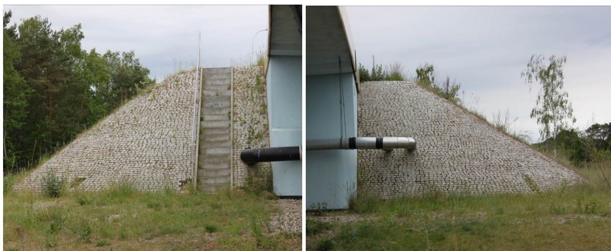
Rys. 3.51. Dojazd do obiektu od strony Karsiboru – umocnienia stożków nasypu przy przyczółku
