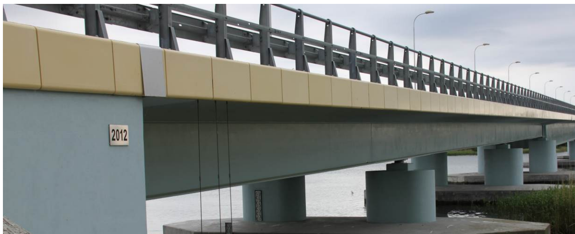
Rys. 3.11. Widok ogólny dźwigarów głównych sekcji trójpřesłowej między podporami nr 1 oraz nr 4 - od strony dolnej wody
