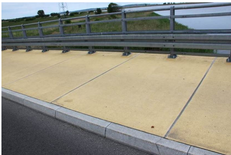
Rys. 3.29. Szczeliny dylatacyjne w konstrukcji i nawierzchni chodnika
