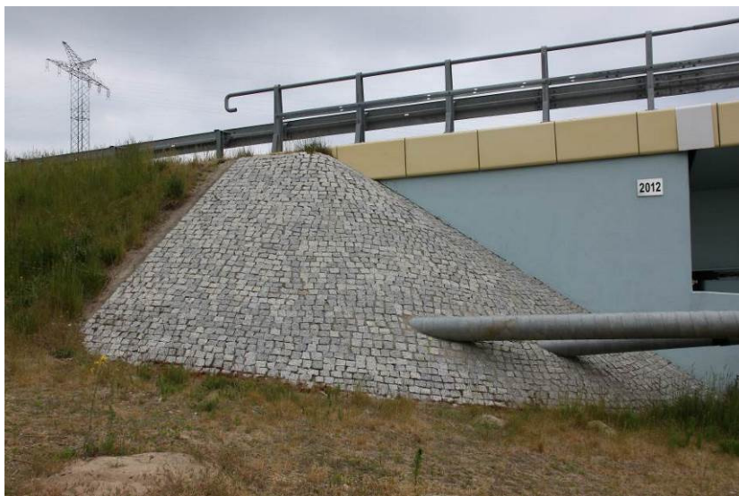
Rys. 3.50. Dojazd do obiektu od strony Ognicy – umocnienia stożków nasypu przy przyczółku
