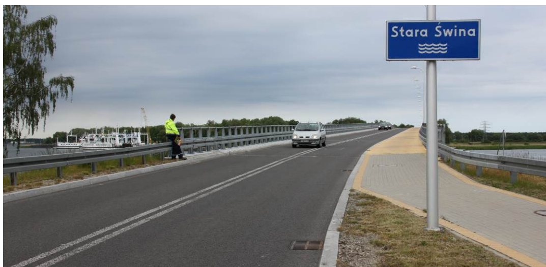
Rys. 2.8. Widok ogólny drogi na obiekcie - z lewego brzegu rzeki Stara Świna
