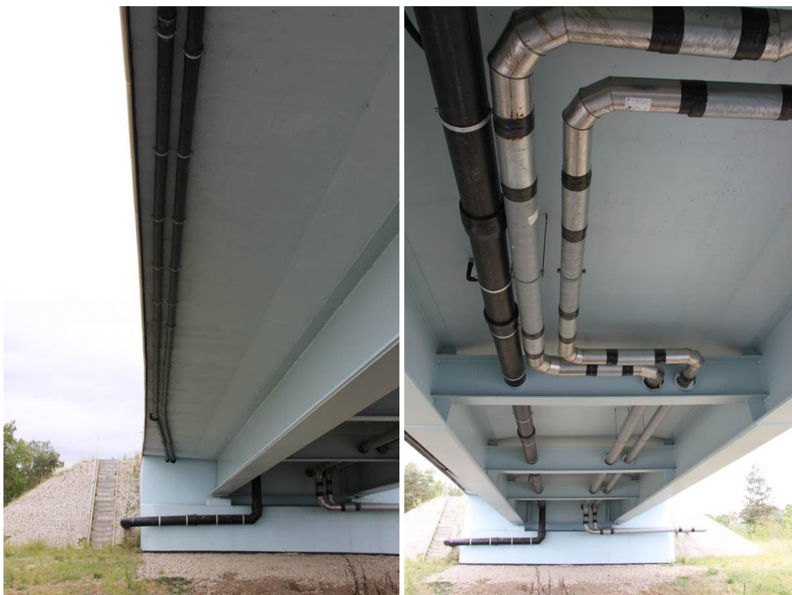
Rys. 3.49. Urządzenia obce zlokalizowane na obiekcie w rejonie podpory nr 10
