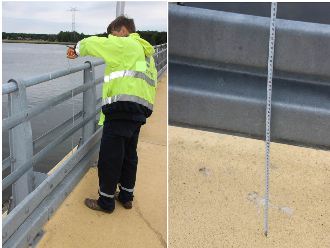
Rys. 4.1. Pomiary kontrolne wysokości bariero-poręczy
