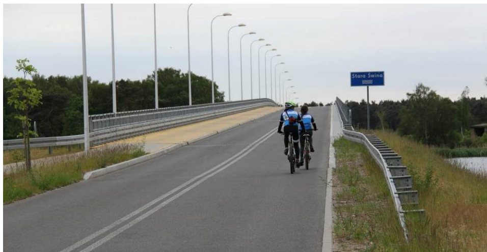
Rys. 3.52. Dojazd do obiektu od strony Ognicy – widok od strony dolnej wody
