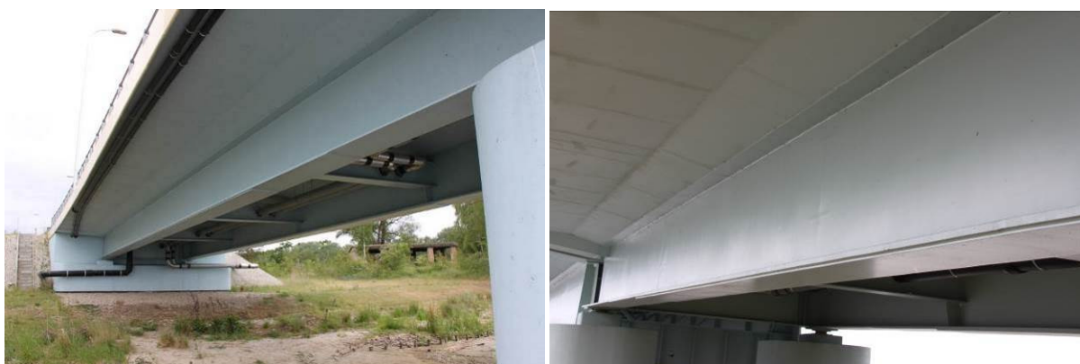
Rys. 3.12. Widok ogólny dźwigarów głównych skrajnego przęsła 9-10 z poziomu lewego brzegu rzeki: od strony górnej wody (po lewej) i dolnej wody (po prawej)
