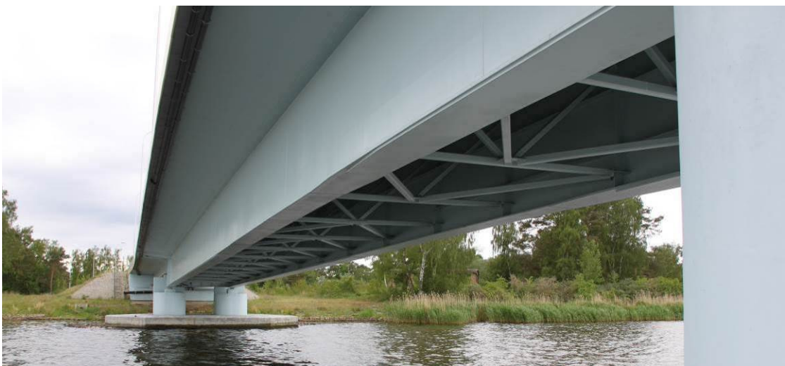
Rys. 2.6. Stężenia kratownicowe w sekcji pięcioprzęsłowej
