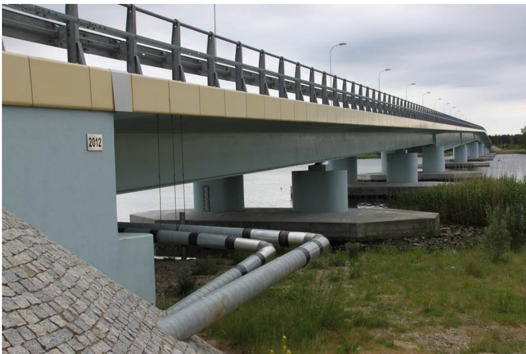
Rys. 3.46. Podwieszenie urządzeń obcych do konstrukcji przęsła w pobliżu podpory nr 1
