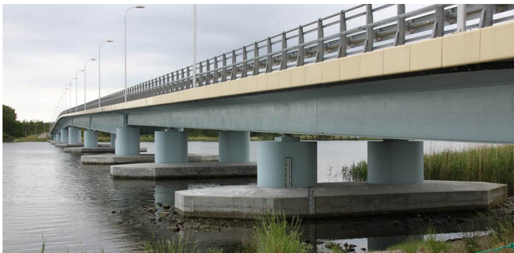
Rys. 2.1. Widok ogólny mostu z prawego brzegu rzeki Stara Świna
