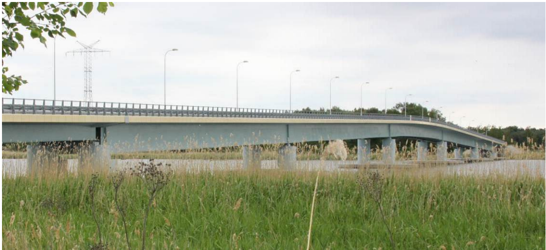
Rys. 2.4. Widok ogólny sekcji pięcioprzęsłowej mostu – między podporami nr 4 oraz nr 9 (widok od strony dolnej wody)
