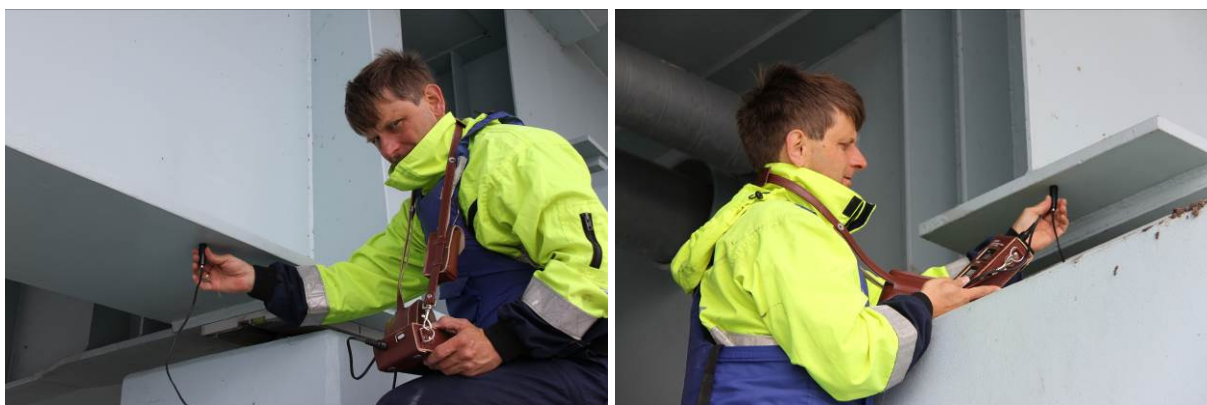
Rys. 4.4. Pomiar grubości powłoki malarskiej pasów dolnych dźwigarów głównych z wykorzystaniem ultrametr (elektromagnetycznego)
