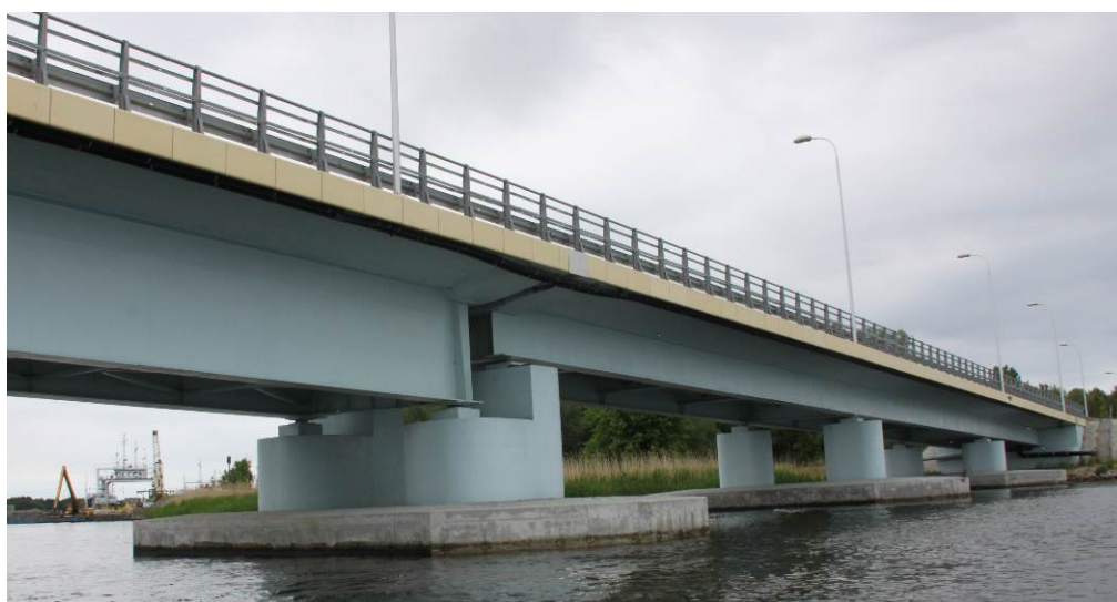
Rys. 2.3. Widok ogólny sekcji trójprzęsłowej mostu – między podporami nr 1 oraz nr 4 (widok od strony górnej wody)
