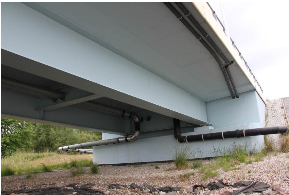
Rys. 3.45. Urządzenia obce usytuowane w rejonie podpory nr 1
