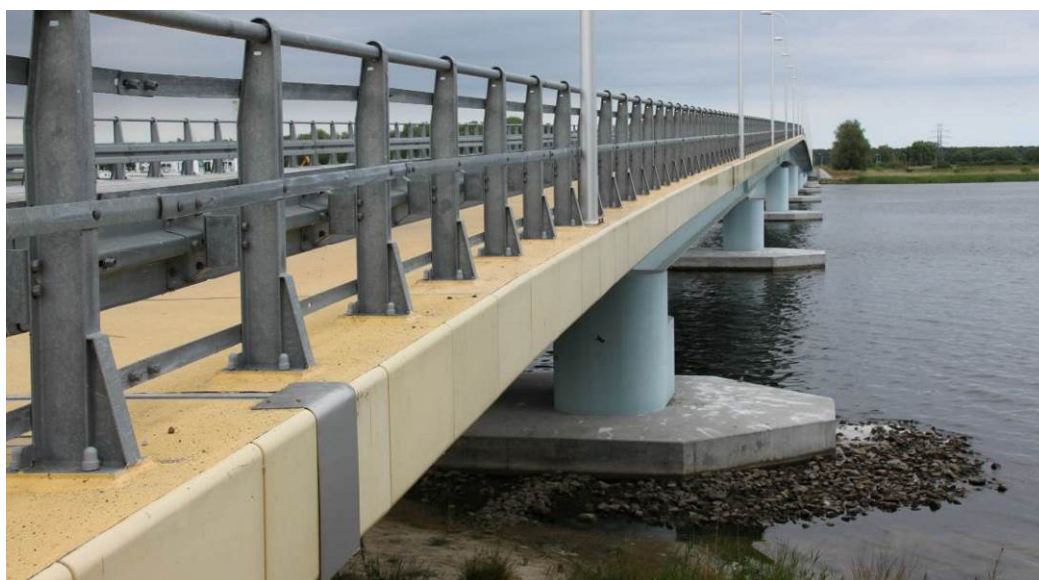
Rys. 2.2. Widok ogólny mostu z lewego brzegu rzeki Stara Świna
