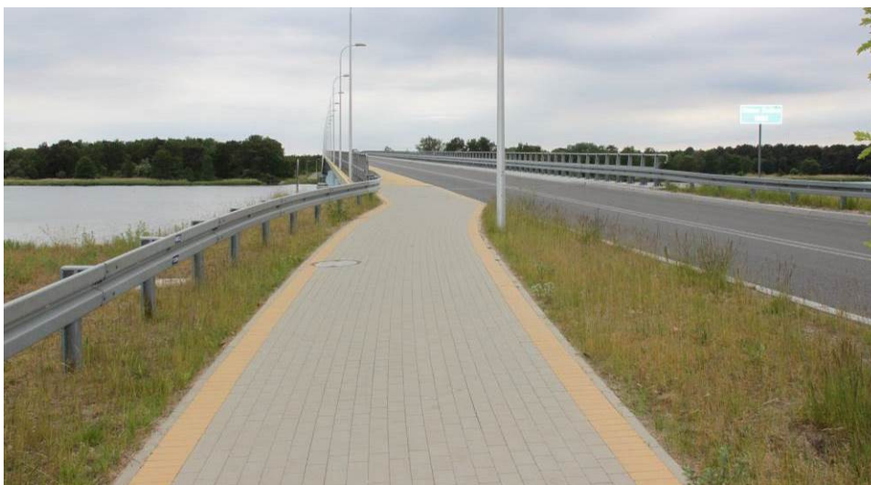
Rys. 3.53. Dojazd do obiektu od strony Ognicy – widok od strony górnej wody
