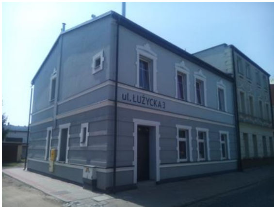
budynek po wykonanej termomodernizacji przy ul. Łużyckiej 3
