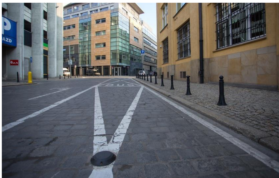
Zdjęcie 18 Przykład czujnika na miejscu postojowym dla autokarów we Wrocławiu
