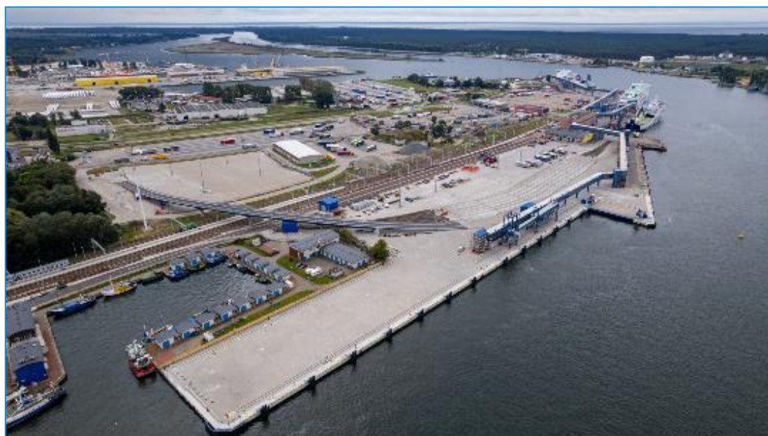
Terminal promowy w Świnoujściu koniec prac budowlanych w ramach zadania pn. „Przystosowanie infrastruktury Terminala Promowego w Świnoujściu do obsługi transportu intermodalnego”.
