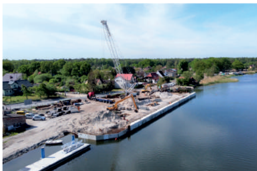
Budowa bazy rybackiej w Karsiborze
