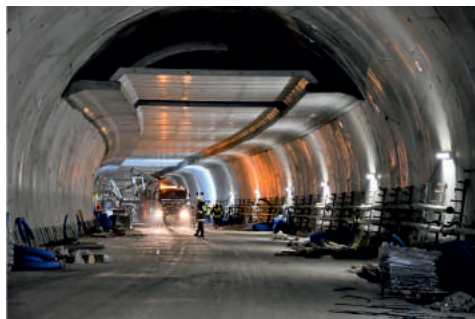
Wnętrze tunelu pod Świną (po lewej wyjścia ewakuacyjne budowane metodą mrożenia gruntu)
