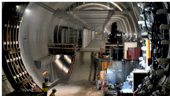
Wnętrze tunelu pod Świną (po lewej wyjścia ewakuacyjne budowane metodą mrożenia gruntu)
