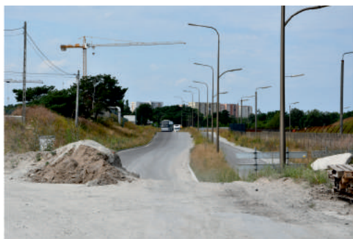
Dokończenie drogi łączącej Centrum Usług Mulnik ze Wschodnią Obwodnicą Miasta
