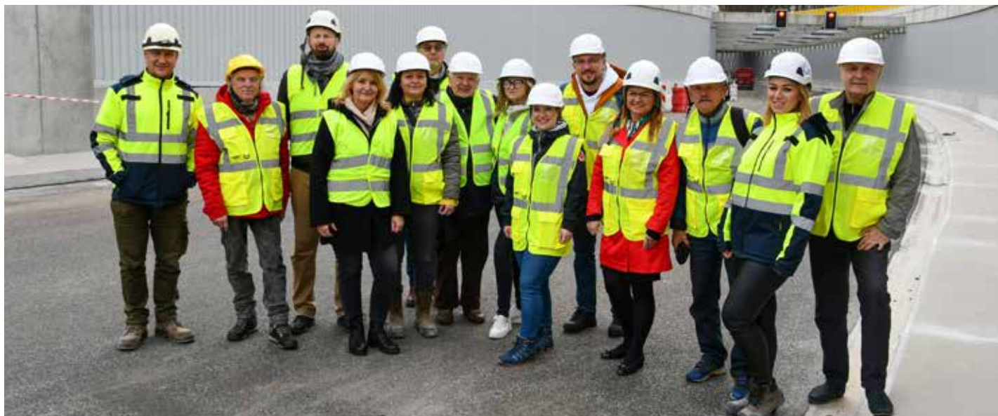
W maju radni odwiedzili największą inwestycję w Świnoujściu – budowę tunelu pod Świną.
