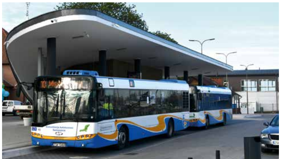
Bardzo ważnym miejscem został nowo wybudowany węzeł przesiadkowy na Warszewie, przy dworcu PKP. To z tego miejsca można dojechać liniami A i B do centrum miasta przez tunel.
