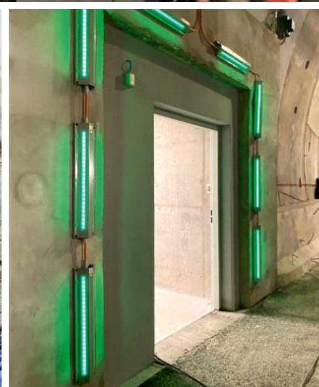
■ Tunel, gotowe już wyjście ewakuacyjne.
