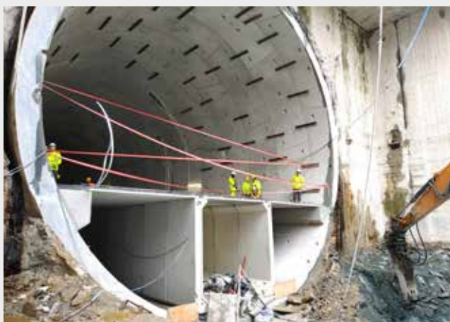
Koniec marca 2022 rok. Na zdjęciu montaż elementów pod przyszłą konstrukcję jezdni i sufitu tunelu (widok od strony wyspy Wolin).
