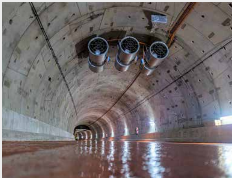
Początek 2023 r. Na przyszłej jezdni widać czerwoną warstwę izolacyjną, którą później przykryje asfalt. To żywica metakrylowa.
