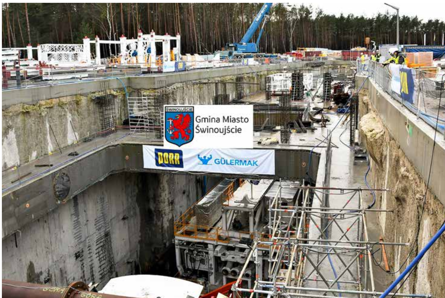
Zima 2020-2021. Montaż maszyny w komorze startowej.
