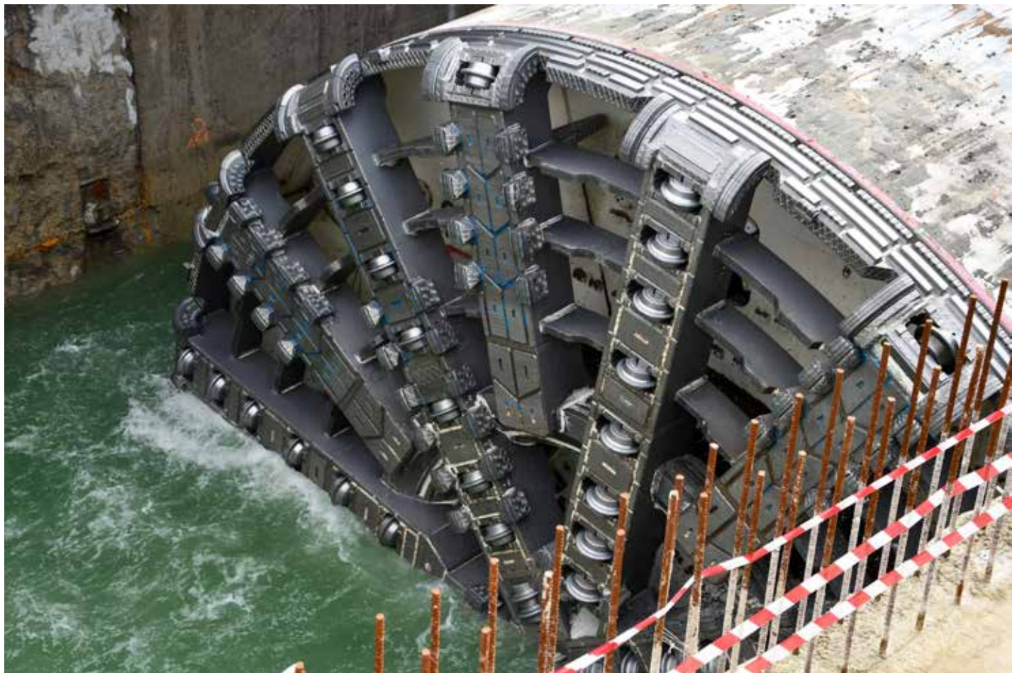
19 września 2021r. Maszyna TBM weszła do komory odbiorczej na wyspie Wolin i zakończyła drążenie tunelu.
