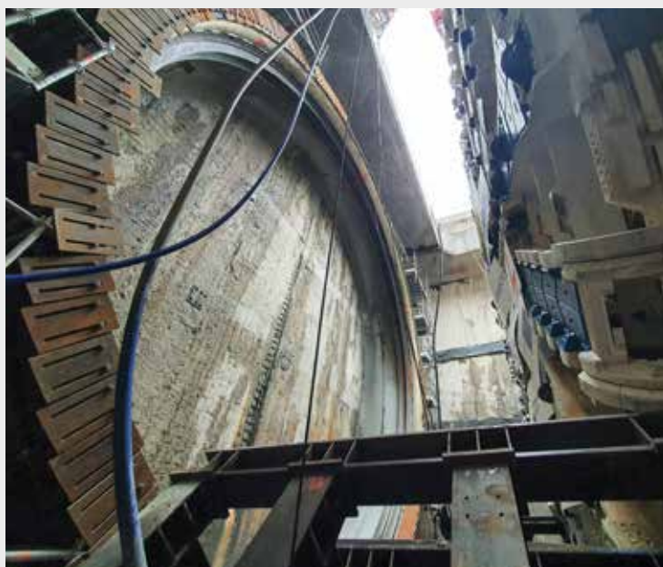
Unikatowe zdjęcie. Po lewej gotowa ściana szczelinowa dla tarczy TMB. Dopiero po jej pokonaniu TBM „Wyspiarka” rozpoczęła właściwe drążenie tunelu. Po prawej widać tarczę TBM.
