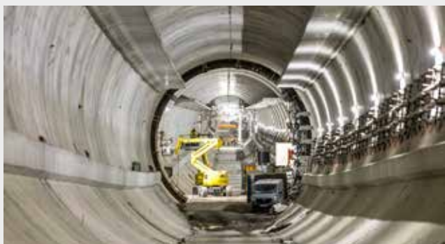
Lipiec 2022 rok. W tunelu jest niemal gotowa konstrukcja przyszłej jezdni i sufitu. Pozostał tylko odcinek, gdzie powstają wyjścia ewakuacyjne poza obudowę tunelu (w głębi zdjęcia).
