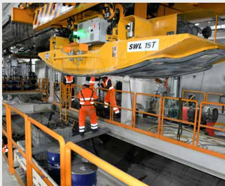
Jeden pierścień obudowy tunelu składał się z 8 elementów tzw. tubingów. Każdy został wyprodukowany dla konkretnego pierścienia. Na zdjęciu ich montaż w tunelu. Łącznie maszyna TBM zamontowała 764 pierścienie obudowy.
