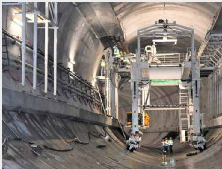
Do montażu wsporników dla konstrukcji wewnętrznych w tunelu pracownicy używali specjalnych wózków typu TULC i TD.
