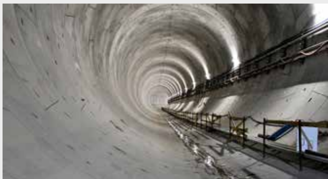
Tak wyglądało wnętrze wydrążone już całego tunelu na początku listopada 2021 r.
