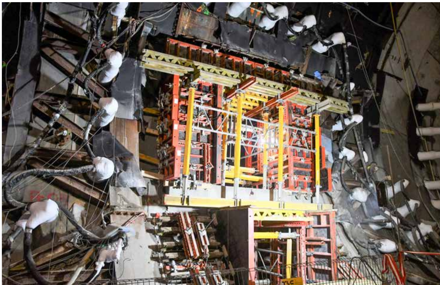
Lipiec 2022. Budowa jednego z wyjść ewakuacyjnych wychodzących poza obudowę tunelu. Wokół widać część instalacji, która mroziła grunt solanką o temperaturze -35 stopnie Celsjusza.
