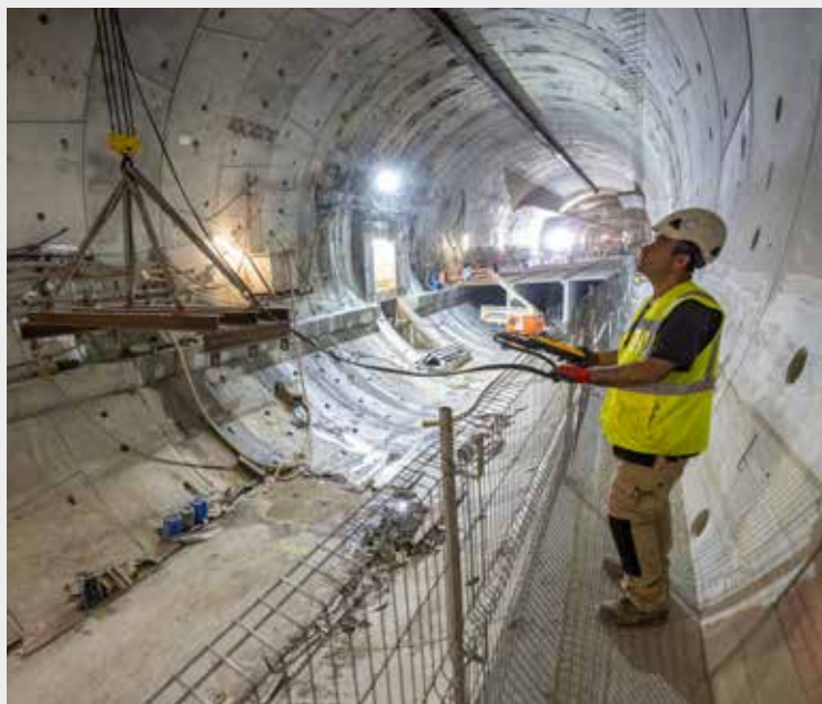
Budowa konstrukcji jezdni.
