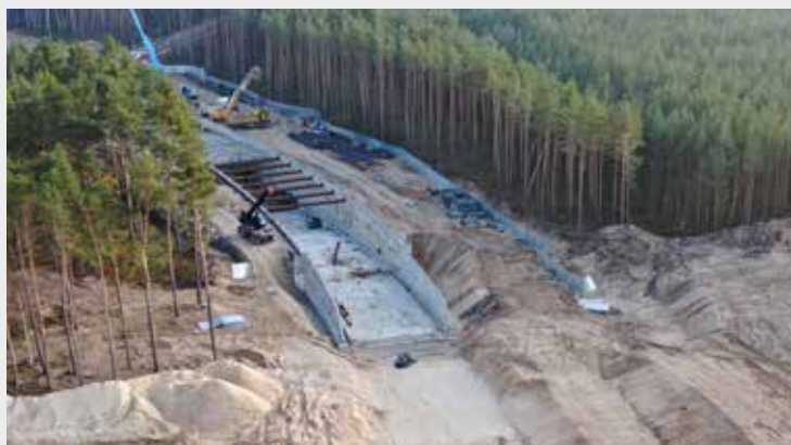
Listopad 2020 r. Budowa tunelu po stronie wyspy Uznam widziana z lotu ptaka
