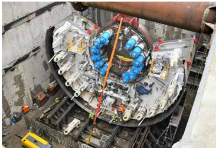
Część tracy TBM w trakcie montażu.
