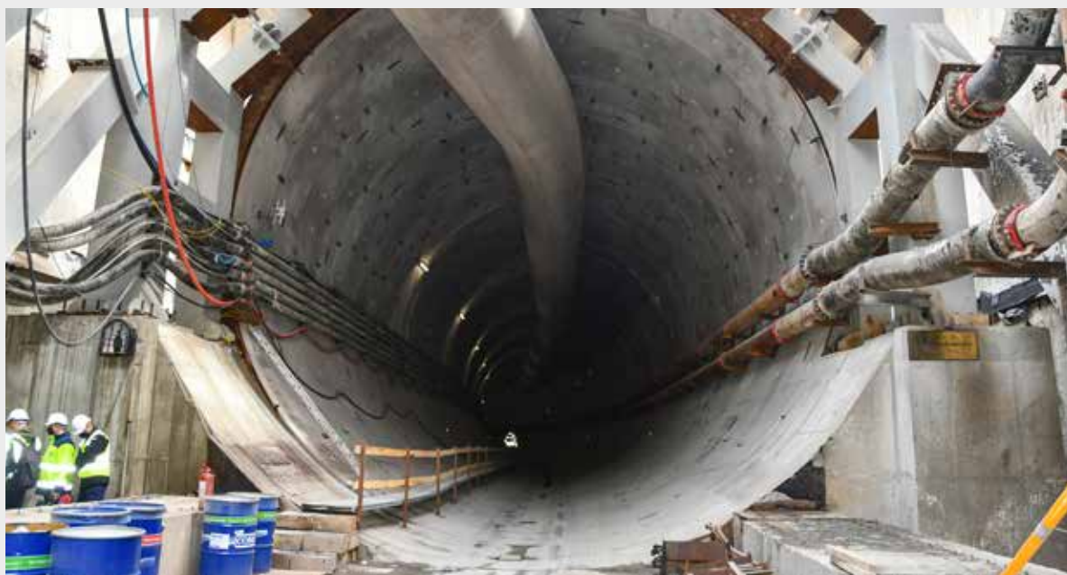
Jeden pierścień obudowy tunelu składał się z 8 elementów tzw. tubingów. Każdy został wyprodukowany dla konkretnego pierścienia. Na zdjęciu ich montaż w tunelu. Łącznie maszyna TBM zamontowała 764 pierścienie obudowy.
