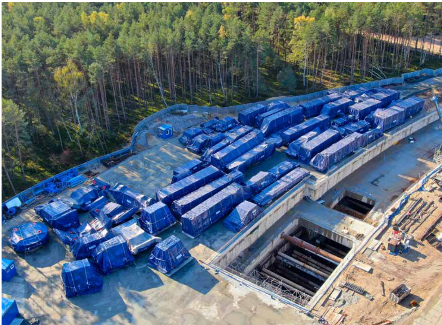
Październik 2020r. Część elementów TBM już na placu składowym. Obok komora startowa, w której została złożona maszyna i skąd rozpoczęła drążenie.
