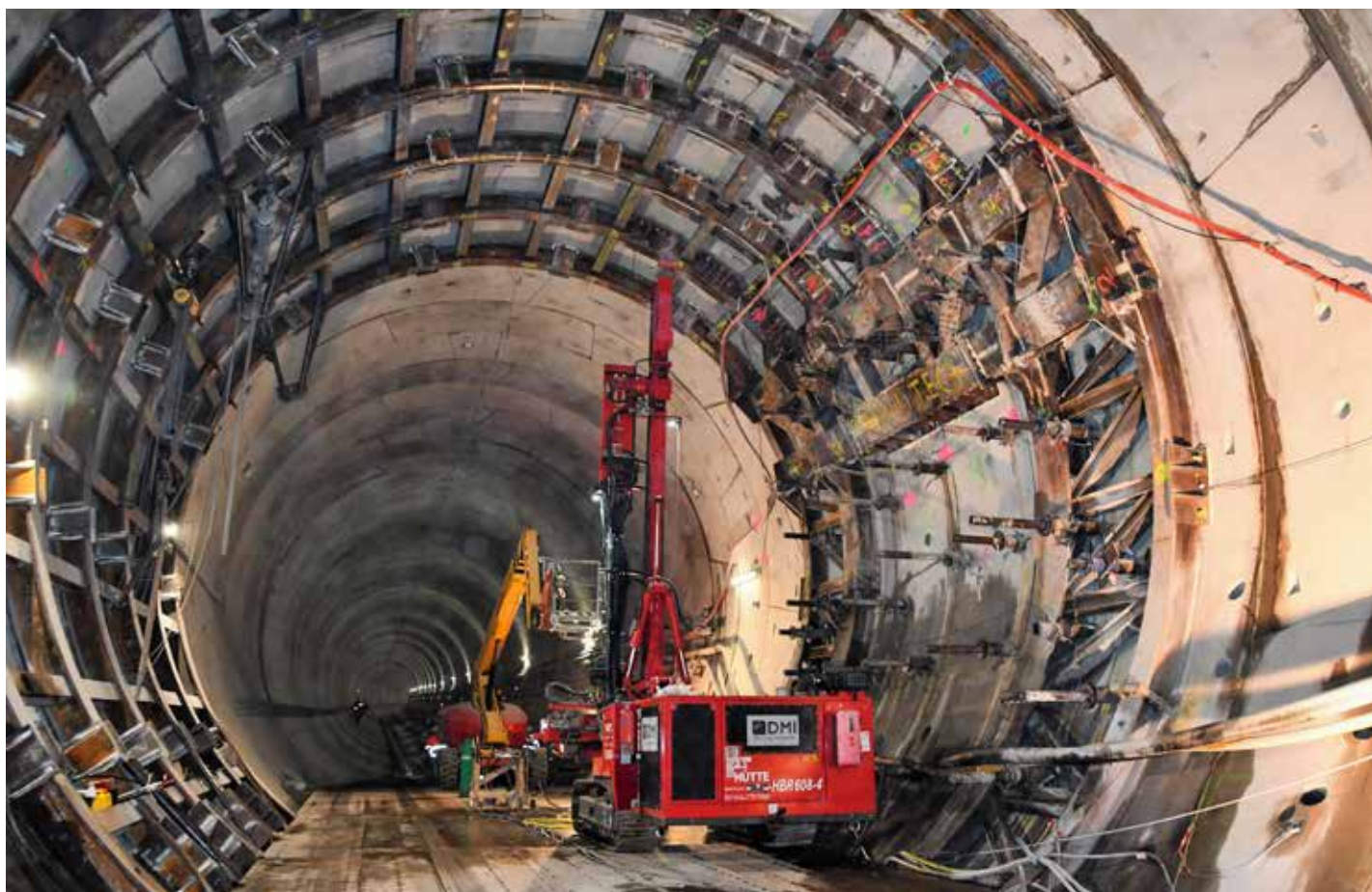
Grudzień 2021r. Przygotowania do mrożenia gruntu poza obudową tunelu.
