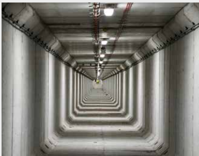
Tak wygląda droga ewakuacyjna, która będzie biegła pod jezdnią.
