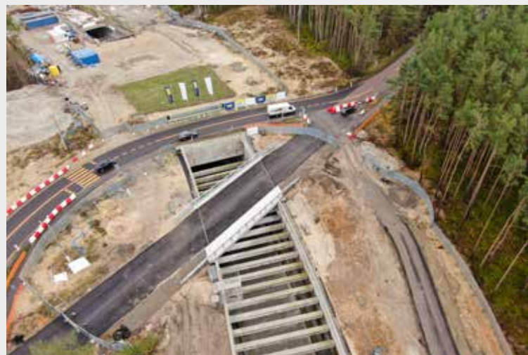
Początek 2022 roku. Budowa tunelu po stronie wyspy Uznam widziana z lotu ptaka.
