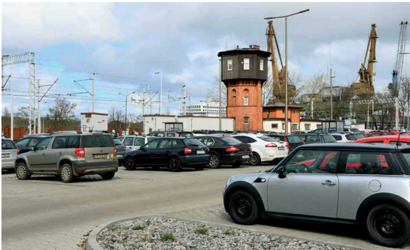
Na wyspie Wolin, w ramach przebudowy węzła przesiadkowego, powstał parking na 125 miejsc przy ulicy Barlickiego (wjazd od ulicy Okólnej).
