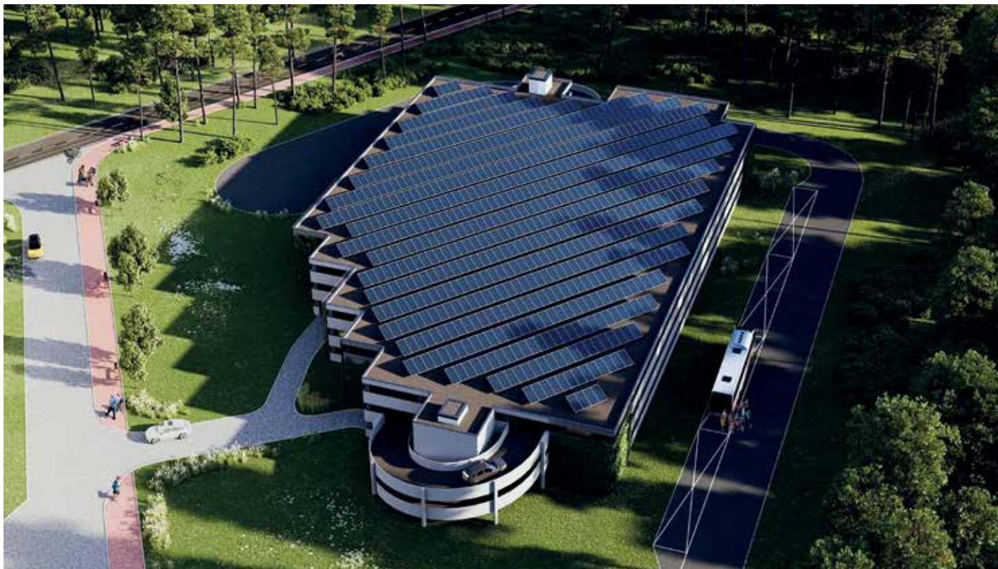
Koncepcja nowego parkingowca przy ul. Zdrojowej / Uzdrowiskowej przewiduje blisko 500 miejsc postojowych, zlokalizowanych na poziomach -1, 0, 1 i 2. Na dachu budynku (poziom 3) przewidziano przestrzeń na panele fotowoltaiczne.
