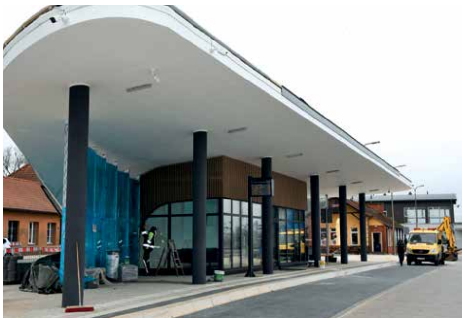
Kończy się budowa węzła przesiadkowego na Warszawie.
