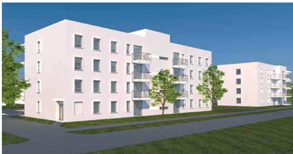
TBS Lokum będzie realizował budynki komunalne z 64 mieszkaniami i przebudowę połowy budynku mieszkalnego przy ulicy Modrzejewskiej 20. Nowe budynki powstaną przy ulicy Ludzi Morza.
