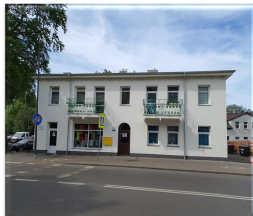
Budynek po rewitalizacji
